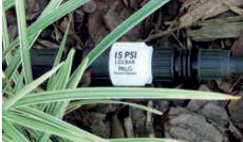
Le PRLG (Pressure Regulator Landscape Grade) est idéal pour les installations nécessitant des débits faibles de 0,5 à 7 gpm (114 à 1590 l/h).
